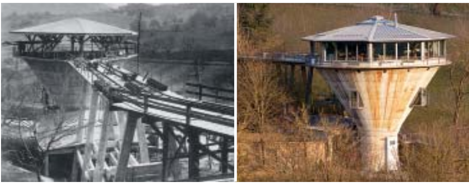
UMFUNKTIONIERT Das Bild links zeigt die Zufahrtsbrücke zum Silo anno 1941. Am Rand der heutigen Wohnung (Bild rechts) kippten früher Grubenwagen abgebautes Erz ins Silo. Die Brücke dient heute als Zugang.
